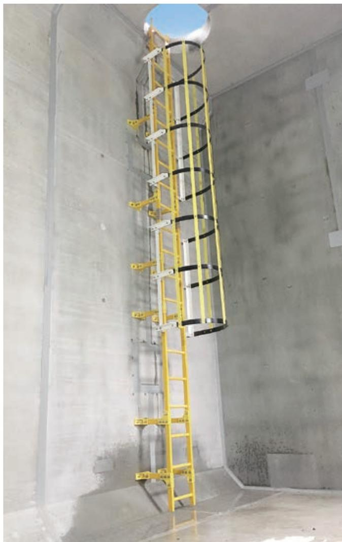
サークル部にはCFRP(カーボン)を使用。
