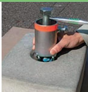
アンカーにセフティポストをボルトで固定する。
