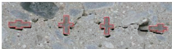
コンクリートを打設したドーナツ型スペーサーの切断面
