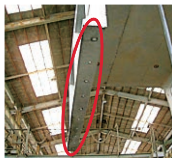
脱型後、ヘッドが折れ、キャップが残る。
