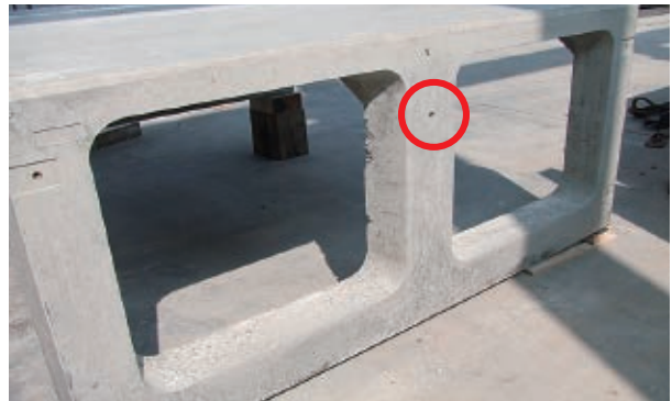
TLインサート取り付け例
