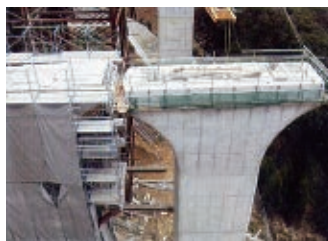
高速道路橋脚
