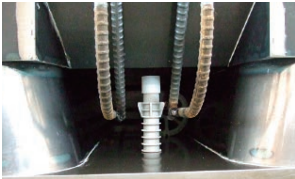
型枠取付治具への取付例。
