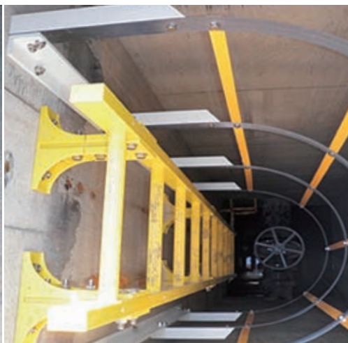
リアガードと FRP 梯子の施工例
